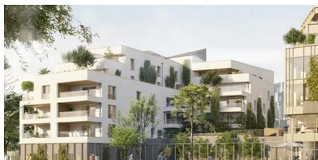
Le projet Imaprim comprend deux immeubles, l'un composé de 36 logements et l'autre abritant des bureaux et services. Le bâtiment d'habitation offre un haut niveau d'isolation à répartition mixte, d'une étanchéité à l'air poussée et de profils de menuiserie fins pour plus de surfaces vitrées et de lumière naturelle. Le bâtiment de bureaux, agrémenté de panneaux photovoltaïques sur le toit, mélange béton, bois et métal.
